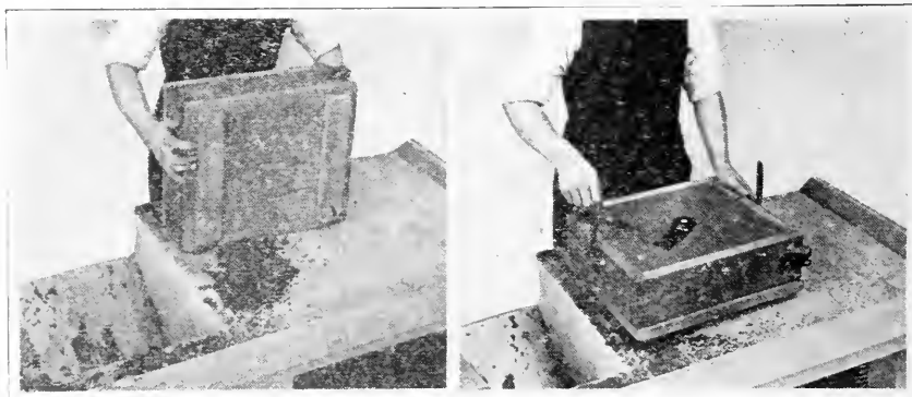
FIG. 502. ROLLING OVER DRAG FLASK.
